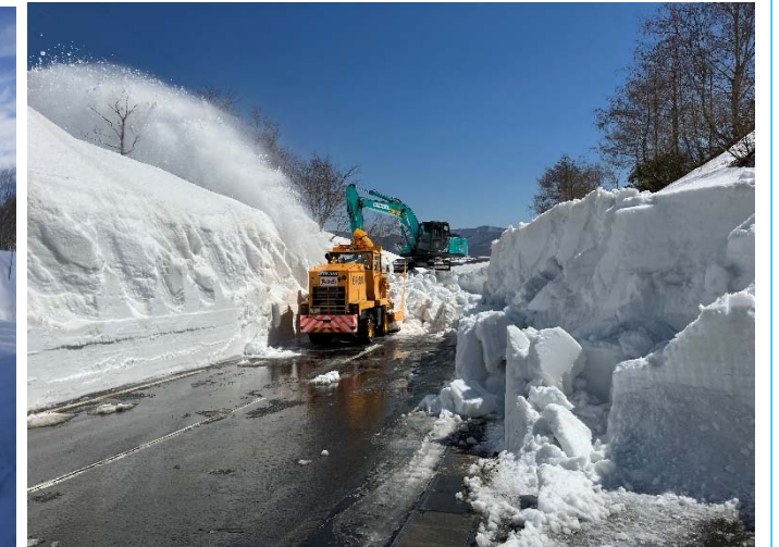
場内除雪状況（2023.4）
