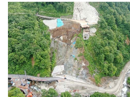
左岸重機道路
