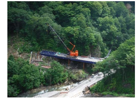
右岸工事用道路
