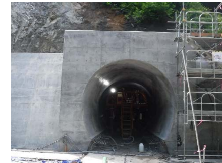
堤外仮排水トンネル
