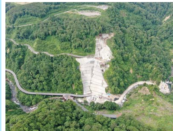
ダムサイト（右岸より）
