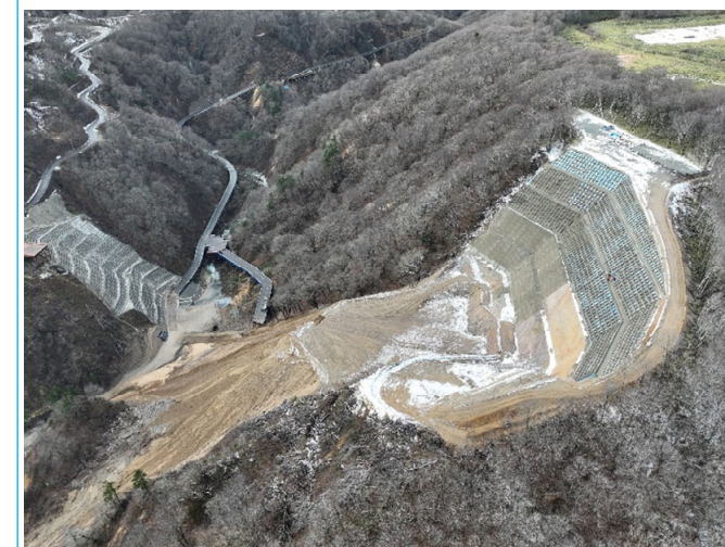
右岸基礎掘削（2024.11）
