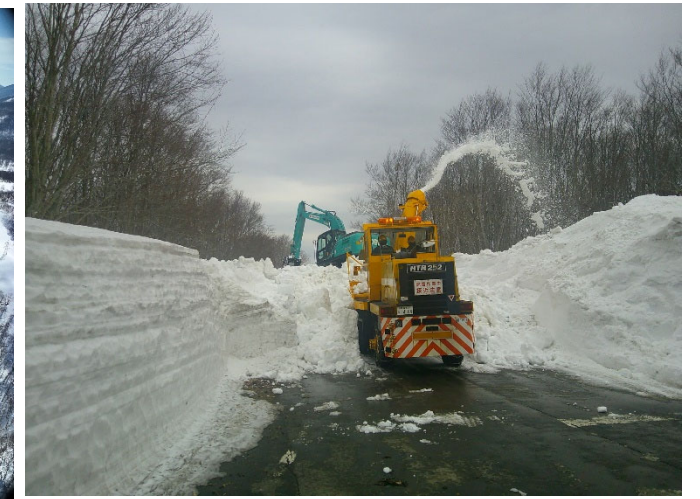
場内除雪状況
