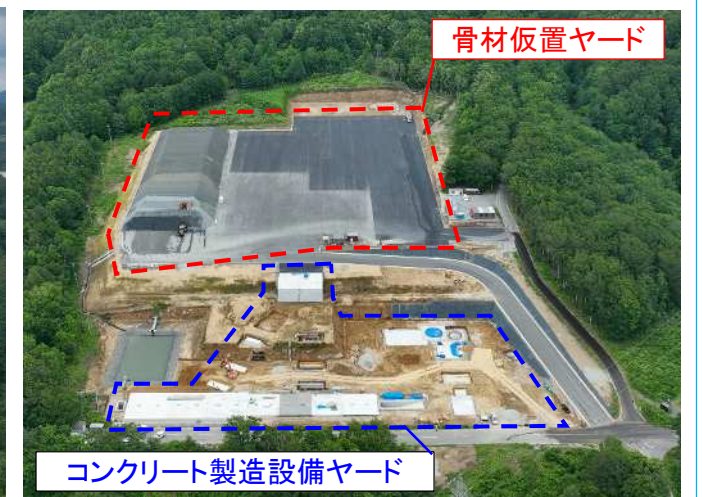
仮設備ヤード（R8.6.25）
