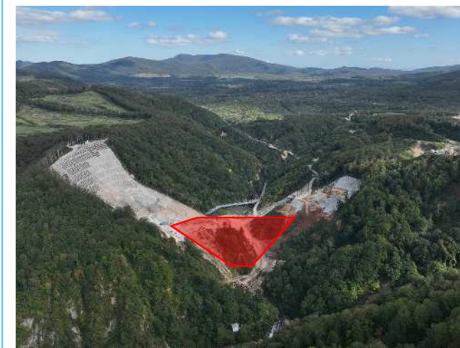
下流より全景（R8.9.30）
